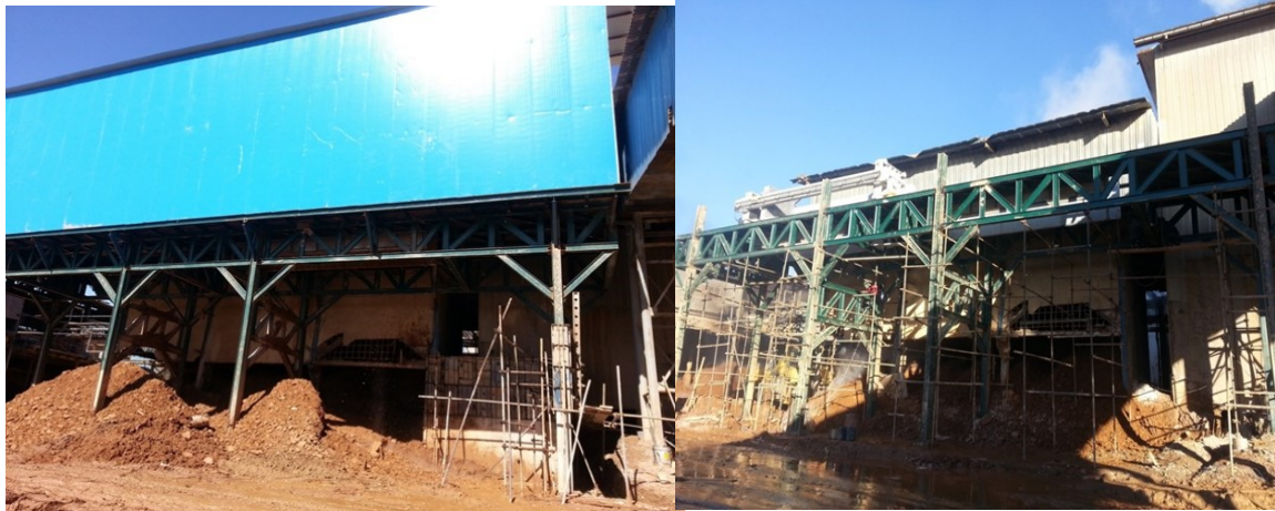
پروژه ساخت و نصب استراکچر و فیلتر پرس کارخانه روی دندی
